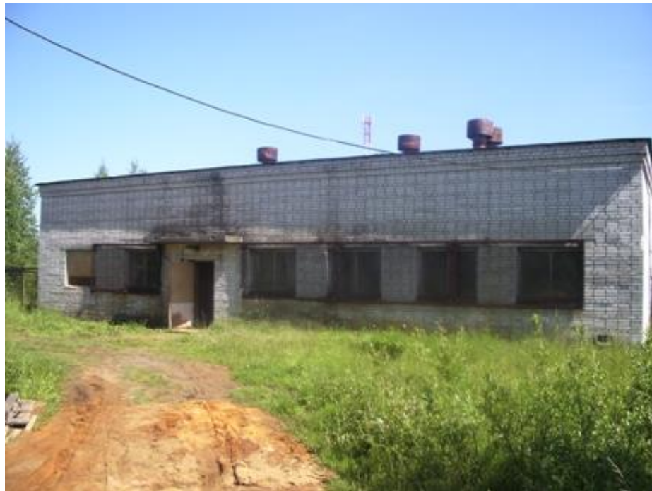
Рис. 9. Вид здания ВОС пос. Вартемяги
